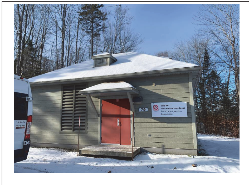
Photo 11 : Poste de surpression – 2020-11-03
