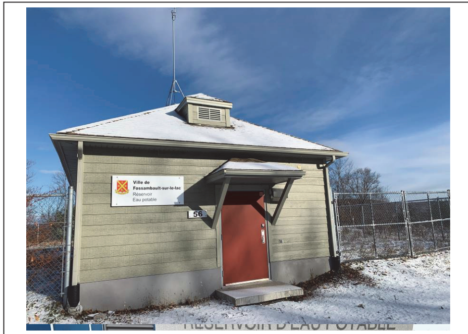
Photo 13 : Poste de distribution – 2020-11-03
