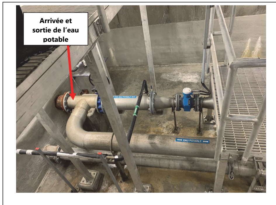
Photo 15 : Canalisation du poste de distribution (Photo 1 de 2) – 2020-11-03
