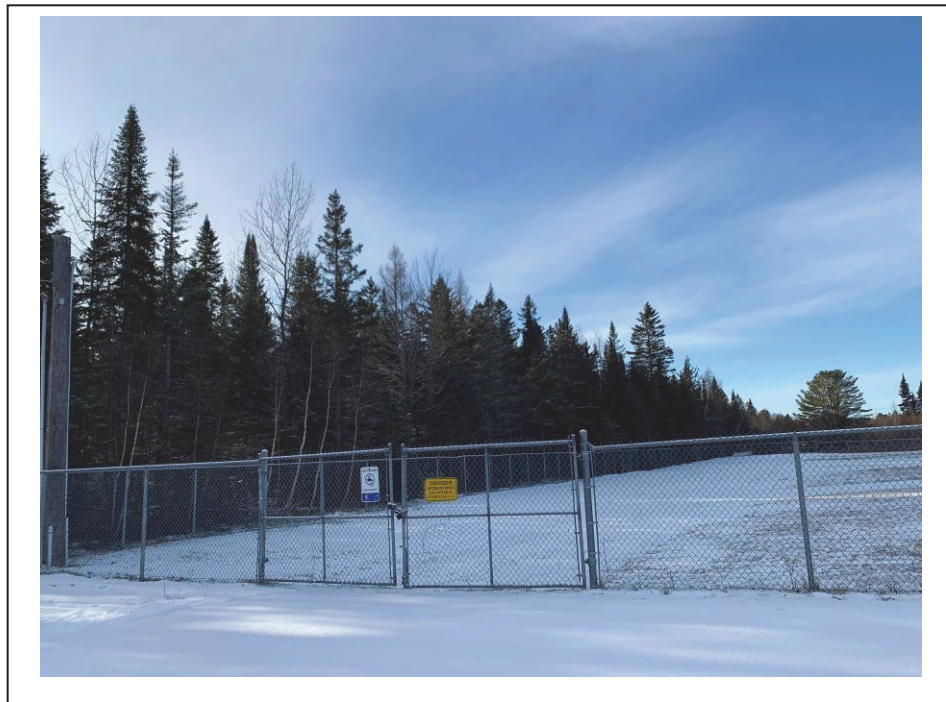
Photo 2 : Accès aux puits P-1, P-2, P-4 et P-5 – 2020-11-03
