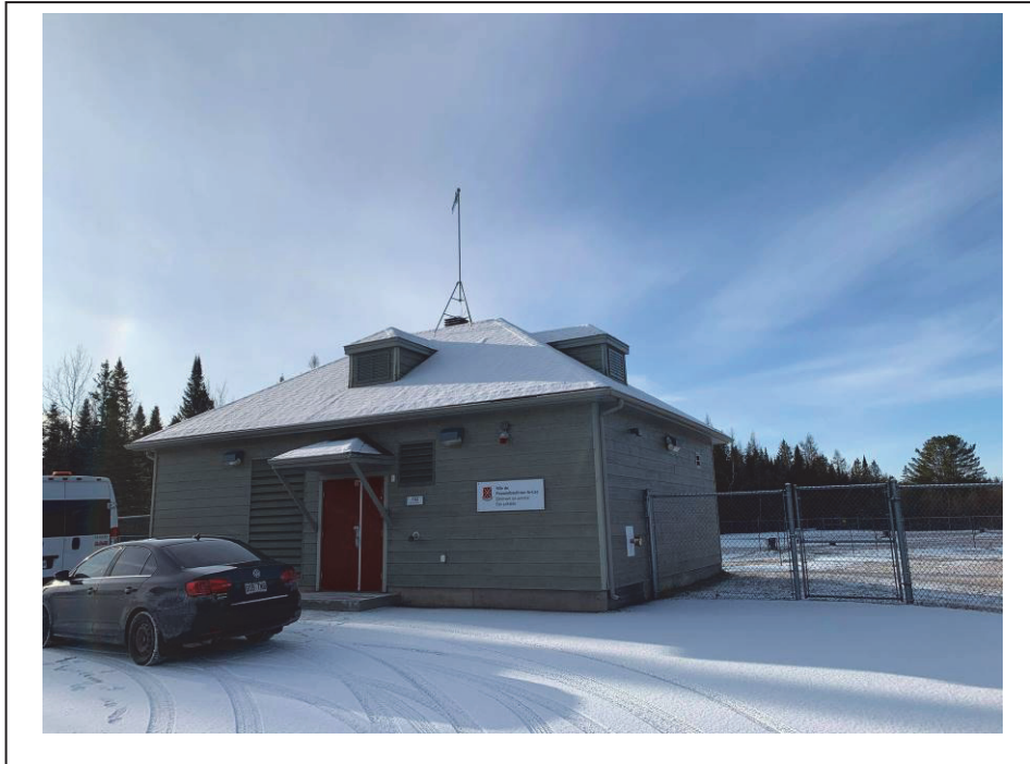
Photo 1 : Bâtiment de service (poste de traitement) – 2020-11-03
